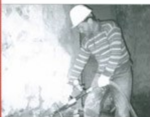
Injection de coulis de ciment à pression contrôlée
