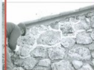
Le débit variable permet d'effectuer des rejointoiments.
