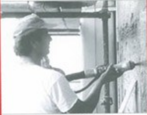
Application d'enduit traditionnel ou pré-mélangé
