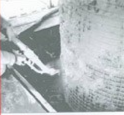
Projection de mortier fibré
