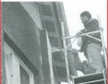
Application d'enduit pré-mélangé
