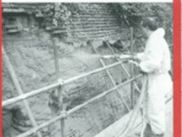
Béton projeté avec S8 SMART
